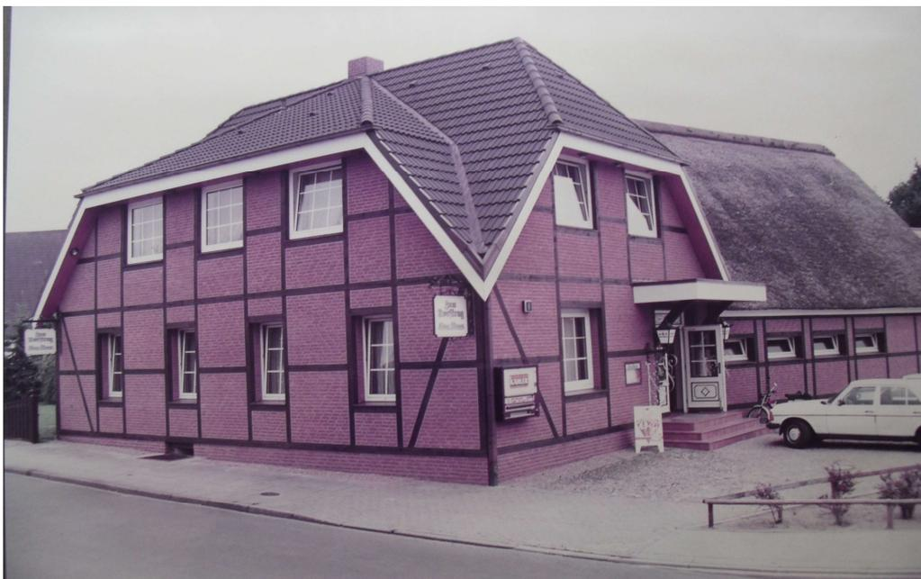
Abb. 11: Der Dachstuhl des Anbaus von 1929 war marode geworden. Deshalb erneuerte Manfred Hauschild, der fünfte Wirt des Dorfkruges, 1984 das gesamte obere Stockwerk und verkleidete das Gebäude gleichzeitig, um die Wärmedämmung zu verbessern.
